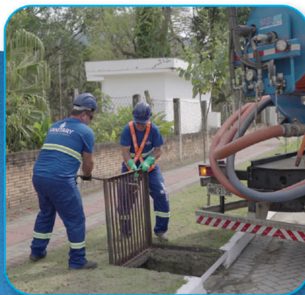
Limpeza de sistema de drenagem
