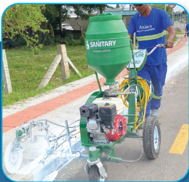
Pintura mecanizada de Meio fio
